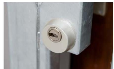
6 Plaque conique de sécurité n° 446 avec protection de carottage. Protection du vérin contre l'arrachement et le perçage.
