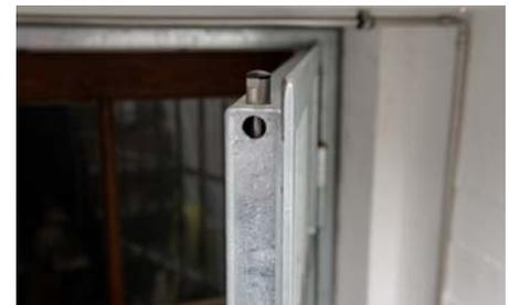
3 Verrouillage vers le haut et vers le bas au moyen d'une serrure avec coffre n° 140UMV.
